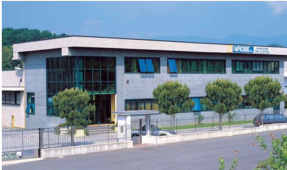
Unità centrale di via Morena 30/4
